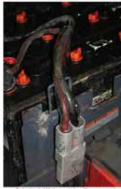
Schritt 4: Während das Ganze noch warm ist, wieder im Stecker stellen, damit der Schrumpfschlauch auf gewünschte Form kühlen kann
